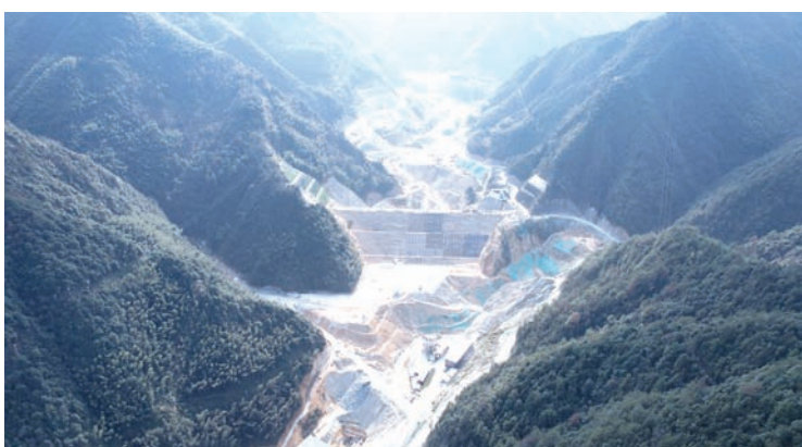
浙江松阳抽水蓄能电站下水库施工面貌。（三峡集团供图）
