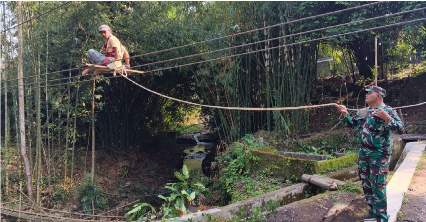
KODIM 0723/KLATEN FOR RADAR SOLO AKSES PENTING: Proses pemasangan pengait jembatan gantung di Desa Kranggan, Kecamatan Manisrenggo, kemarin.
